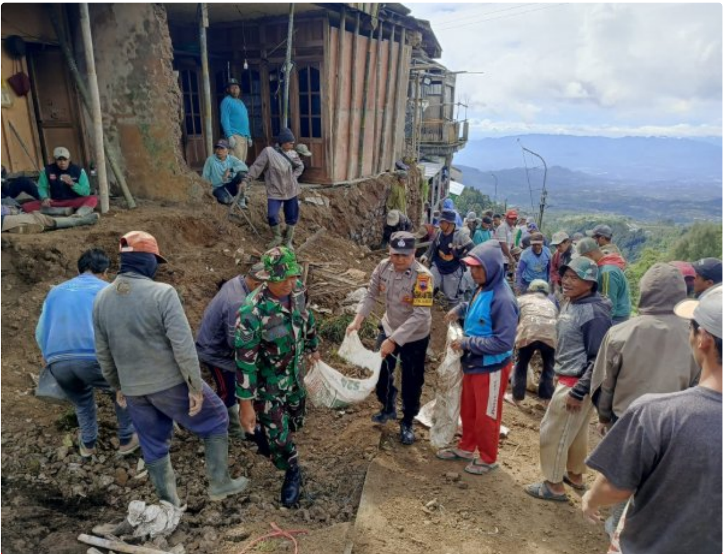
(Foto Dokumen) : Gotong royong pembersihan material longsor
